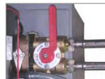
1. S'il n'est pas prémonté, assembler le by-pass et visser les 2 pattes de fixation en Inox situées sur les côtés
